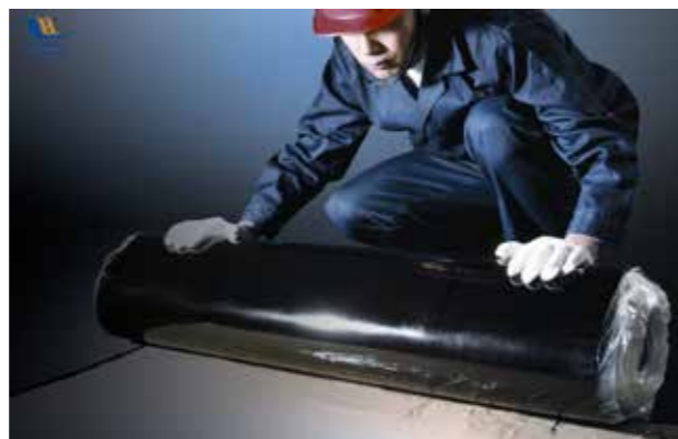
/自粘防水卷材的湿铺法施工/
