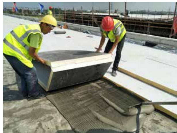
/外喜防水保温一体化板施工，一次解决防水、保温问题/
