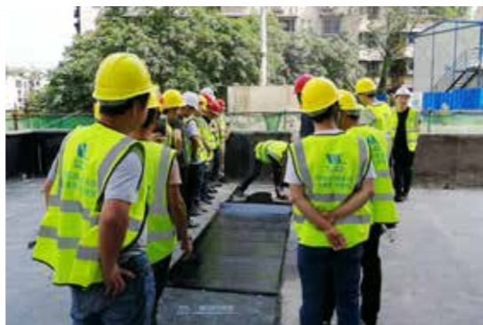
/施工管理团队定期开展施工技能培训/
